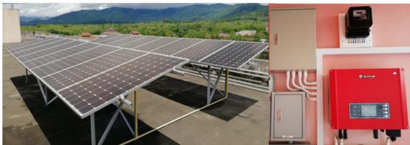
ภาพ 27 ชุดผลิตไฟฟ้าจากโซลาร์เซลล์ขนาด 5 กิโลวัตต์
